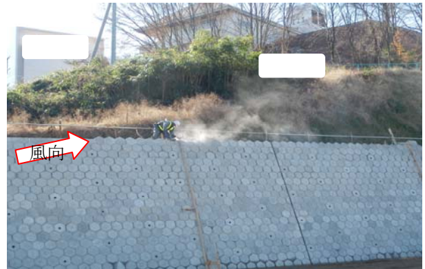
写真1 天端石切断の現場風景
