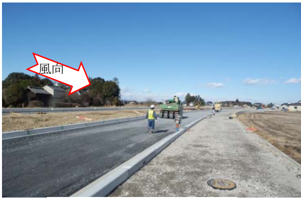
写真2 上層路盤の現場風景
